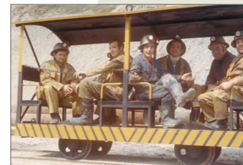
Alcuni operai sul treno all'entrata del cantiere Consorzio Gottardo sud
